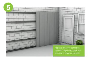
Continue a encaixar as réguas de ripado dessa forma até cobrir completamente a área desejada. É possível encaixar suas réguas lado a lado simplesmente juntando as duas pontas. Pode necessitar de instalar mais vigas se desejar fazer isso, pois cada régua de ripado precisa de ser apoiada numa viga onde se encontre com a próxima régua.
