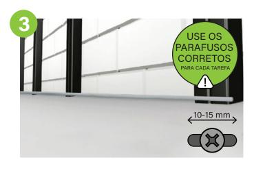
Coloque na base um pequeno sarrafo com 10mm de altura, que posteriormente seja facilmente removível. Encoste a primeira régua de ripado por cima do sarrafo. Pré-perfure 1º os orifícios do parafuso da primeira régua de ripado antes de inserir o parafuso, o comprimento do orifício é sugerido para ser 10-15 mm, deixando assim espaço suficiente para a expansão normal do ripado. Certifique-se a 1ª régua de ripado está
