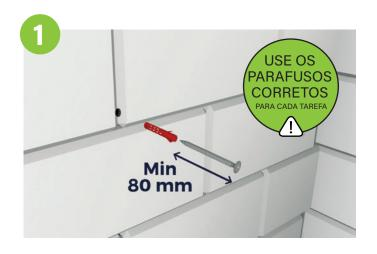
É necessário pré-perfurar as vigas de substrutura e a superfície da parede usando uma broca de 6 mm. Os sarrafos têm 25 mm de altura e é preciso prendê-los pelo menos a 50 mm da extremidade. Escolha as fixações adequadas para a parede em que está a instalar o ripado. Os parafusos devem ter 5-6 mm de diâmetro e pelo menos 80 mm de comprimento.
